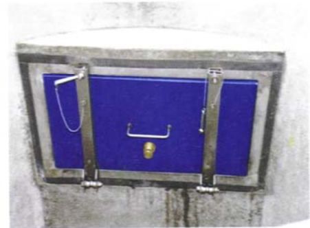
Einhändig verschließbare Revisionsöffnung mit Schnellverschlüssen und der Möglichkeit einer Druck- und Faulgasprüfung.
