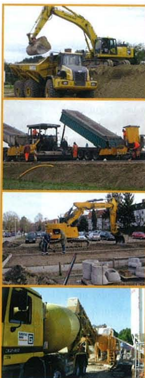
Ein Fahrmascher bringt den Flüssigboden in den Kanal ein. Die Säulen am historischen Rathaus werden bei dieser neuen Technologie vor dem Angriff der Rüttelplatte verschont. Die ungestörte Situation vor der Aufgrabung wird wiederhergestellt.
