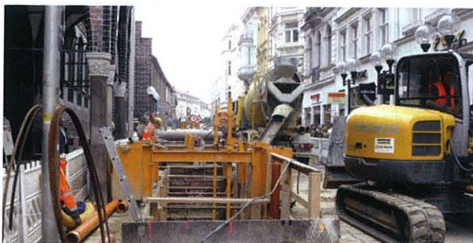
Ein Fahrmascher bringt den Flüssigboden in den Kanal ein. Die Säulen am historischen Rathaus werden bei dieser neuen Technologie vor dem Angriff der Rüttelplatte verschont. Die ungestörte Situation vor der Aufgrabung wird wiederhergestellt.
