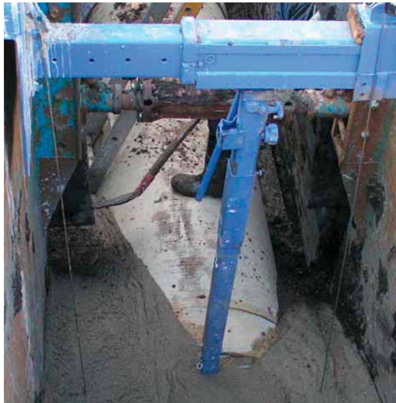
Querschott zur Trennung der Arbeitstakte (getaktetes Verfahren)
