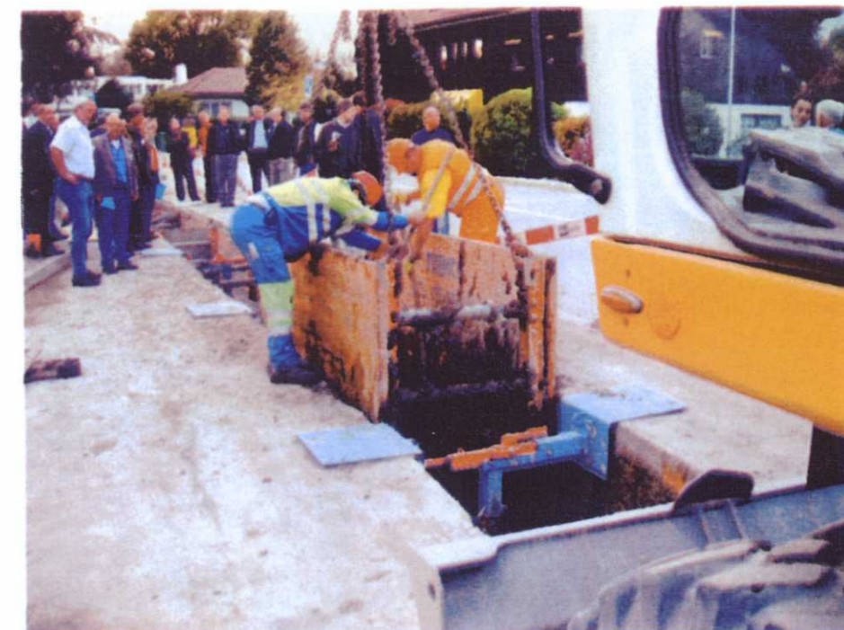
Mise en place du sol fluide sur le chantier de Thielle-Wavre: une démonstration qui en appelle d'autres. (Photo: AJS)
